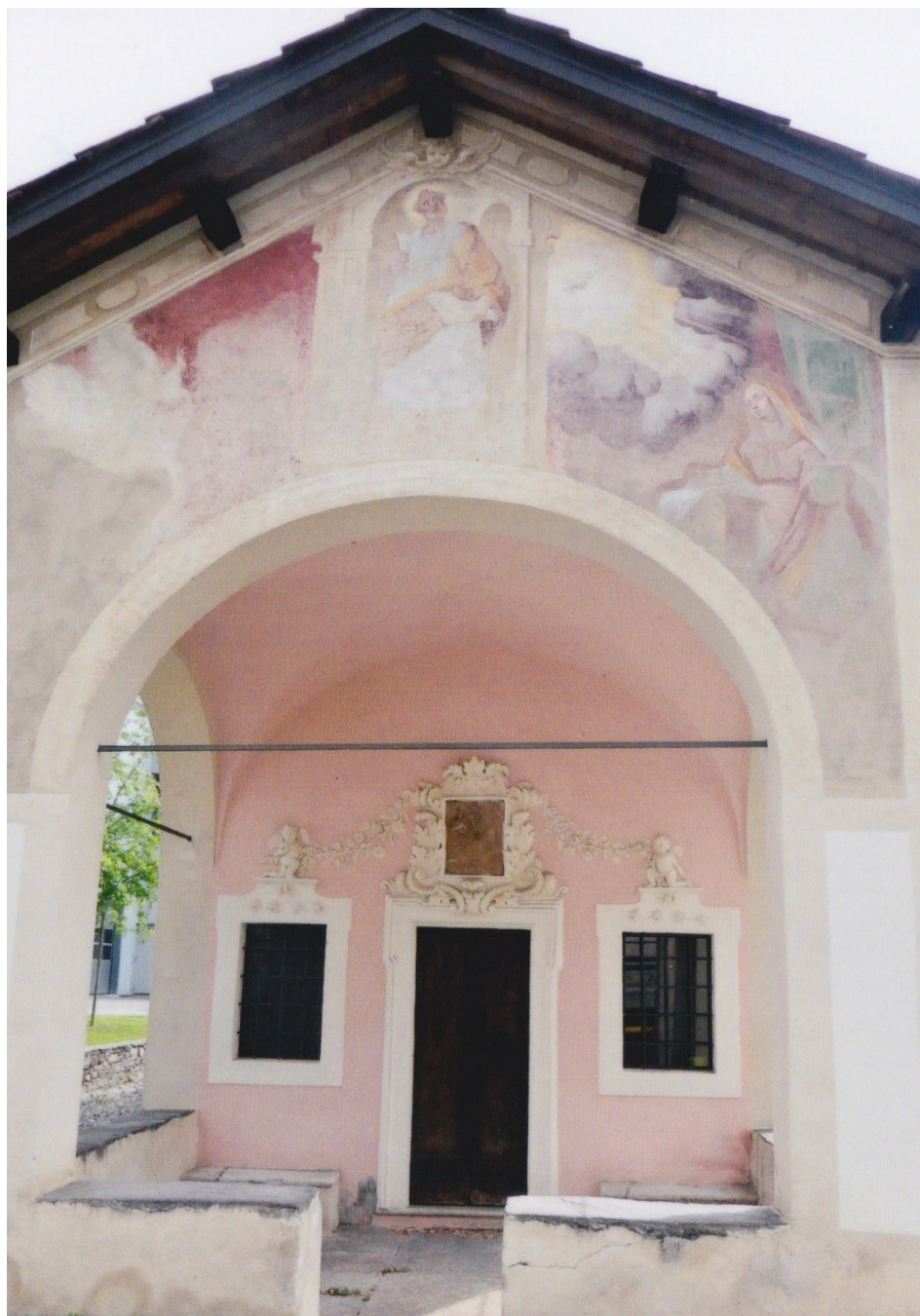
Eingang der Kapelle della Bricola.
